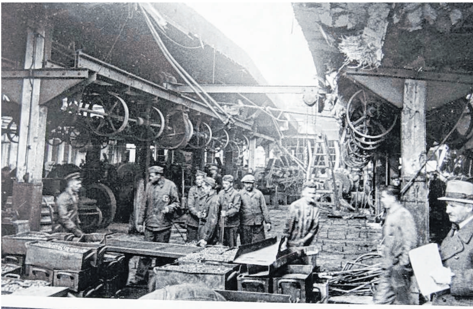
Das Foto zeigt Zwangsarbeiter bei VKF, heute SKF, im zerstörten Bau 50 (Schrottere) im Werk II nach den Oktober-Luftangriffen 1943. Das Foto entstand am 24. Oktober 1943.
